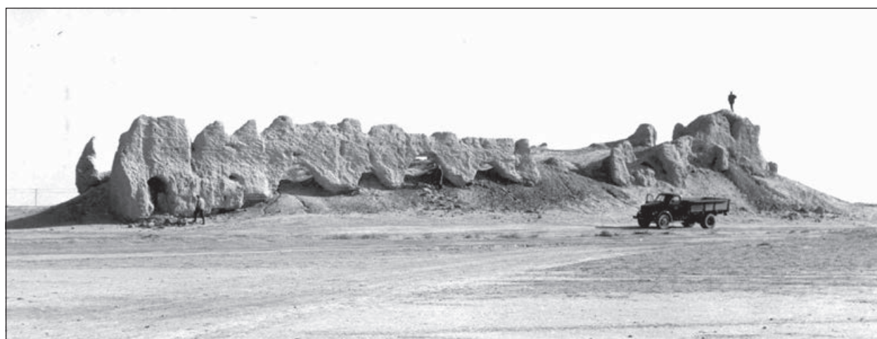
Рис. 6. Хараба-кёшк. Южный фасад. 1966 г. Архив ЮТАКЭ
